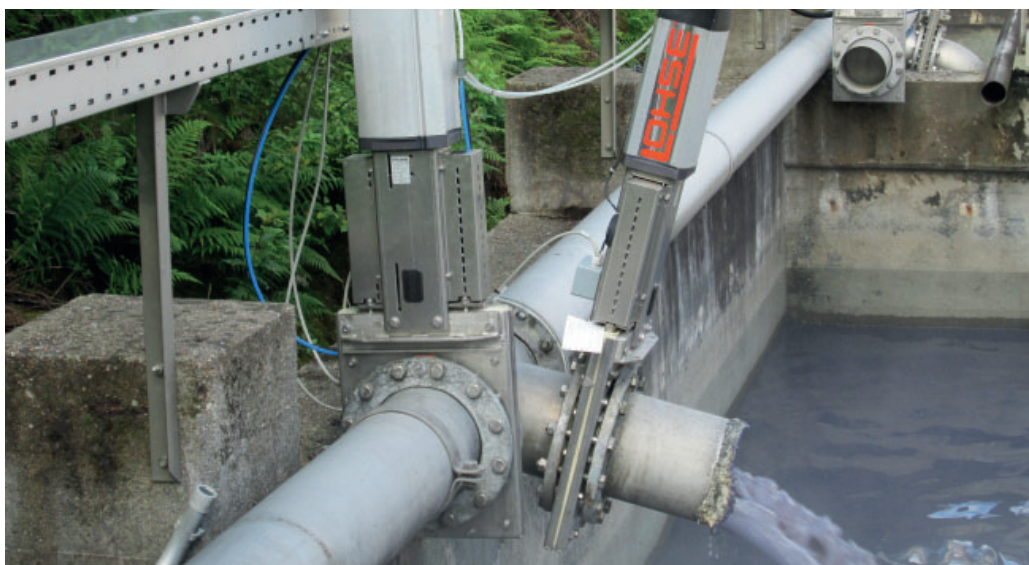
MARTIN LOHSE entwickelte den Absperrschieber der Type CAW speziell für den Abwasserbereich. Nicht-korroderierende Werkstoffe helfen, den Widrigkeiten zu trotzen.
