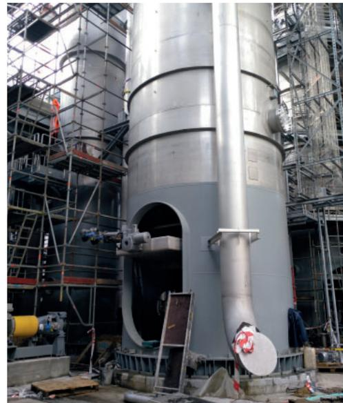
Auslassschieber DN1200 mit elektrischem Antrieb unter einem Stapelturm von 35 m Höhe.
